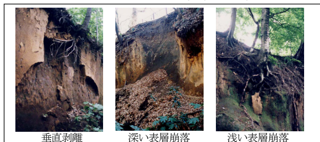
写真1 法面の崩落形態
