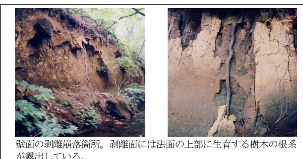
写真3 崩落箇所と根系露出の事例
